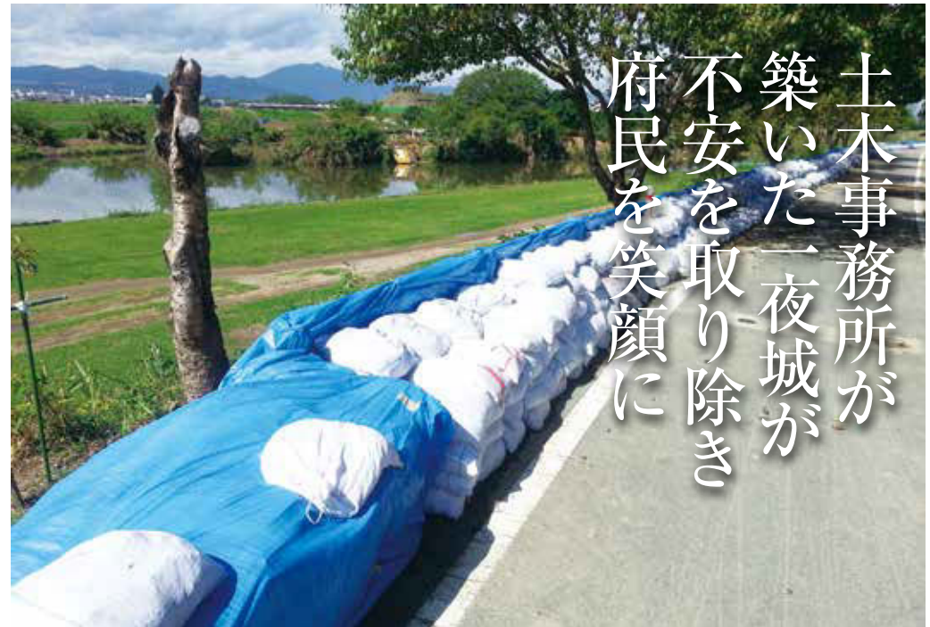
台風24号に不安がる住民の皆さんのために、京都土木事務所が緊急で造ってくれた土嚢の堤防
